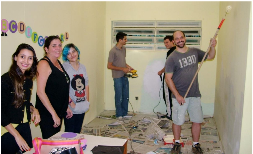
Finalizando o trabalho Fonte: Arquivo da ARIL
